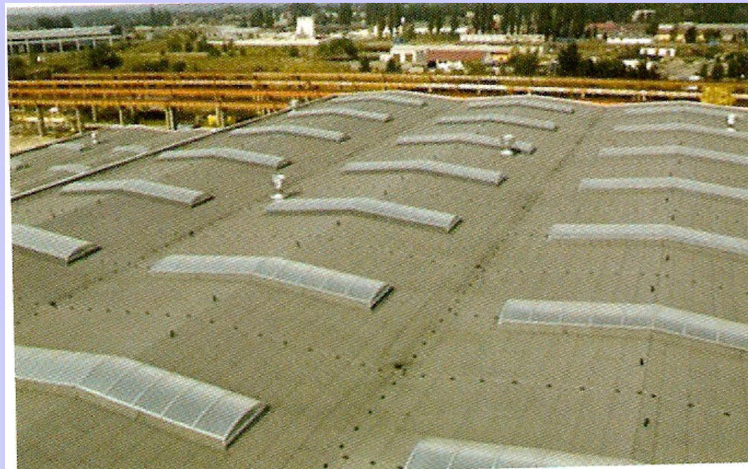
Rys.18. Przykład pasm świetlnych rozmieszczonych prostopadle do kalenicy.
