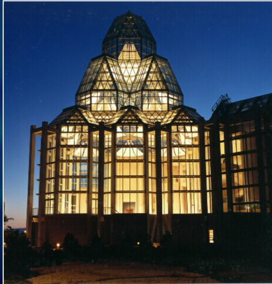
Rys.28. Iluminacja obiektu z wykorzystaniem oświetlenia wewnętrznego
