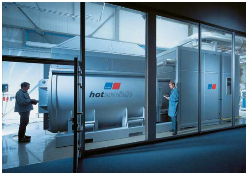
Moduł MCFC w Guericke University Medical Institute w Magdeburgu w Niemczech o mocy 250 kW zainstalowany w 2003r. Koszt 3.5 mln EUR
