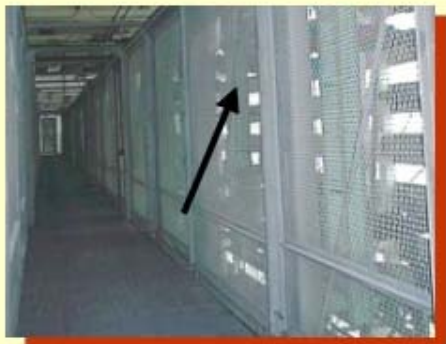
Siatka ekranująca przejście
