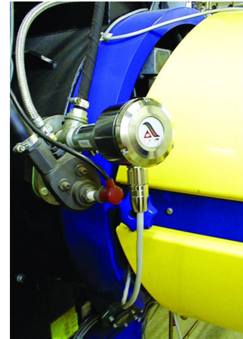
Wygląd skanera płomienia (podczerwień, ultrafiolet i jonizacja płomienia)
