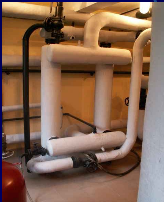
Rys.7. Wymienniki C.O. i C.W.U. wraz ze zbiornikiem ciepłej wody w węźle ciepłowniczym jednego z akademików Miasteczka Studenckiego AGH
