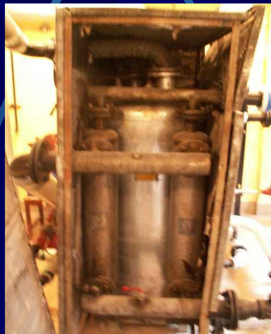
Rys.7. Wymienniki C.O. i C.W.U. wraz ze zbiornikiem ciepłej wody w węźle ciepłowniczym jednego z akademików Miasteczka Studenckiego AGH
